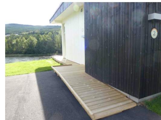
Fin rampeløsning inn til campinghytte, med stoppkant slik at ingen triller utfor kanten
